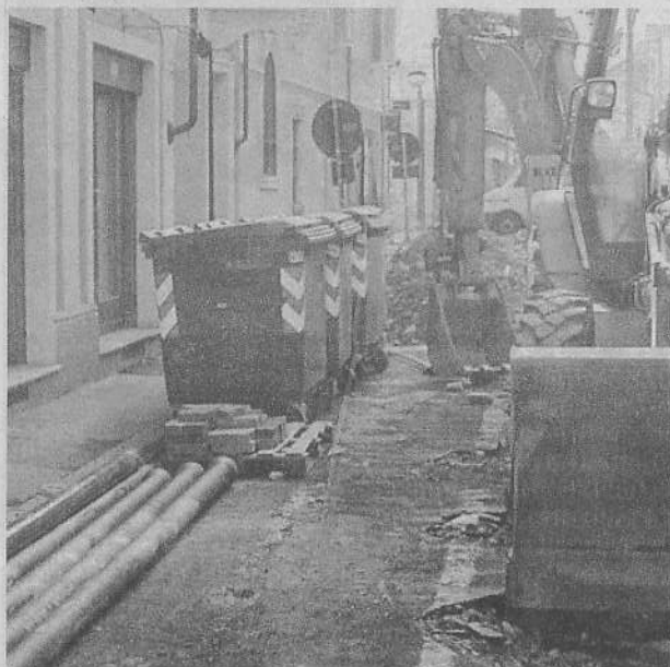
Ancora lavori in città per gli allacciamenti del teleriscaldamento
