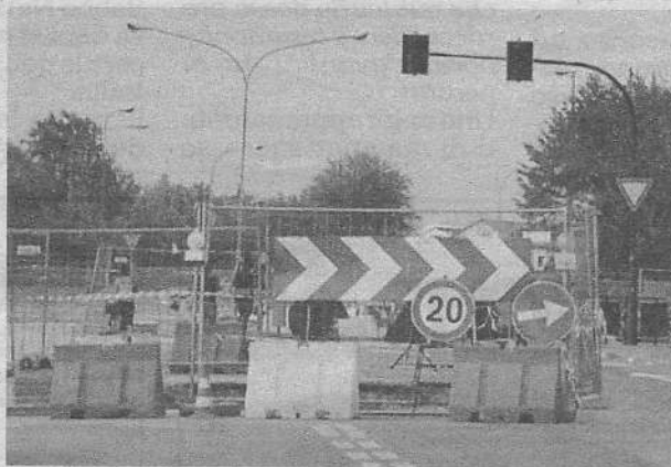
I lavori ad una delle rotonde di via Torino
